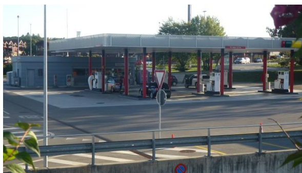
Vue depuis l'est sur la station-service
